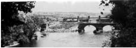
Alte Neckarbrücke zerstört – um 1945
