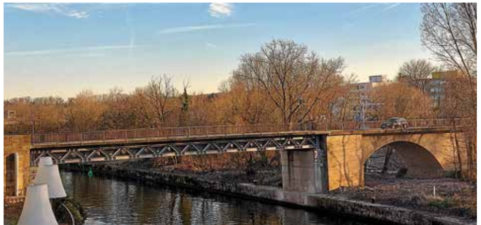
Mittlerweile wurde die Kanalbrücke mit Hilfsträgern befestigt, damit ein Befahren bis zum Neubau möglich bleibt
