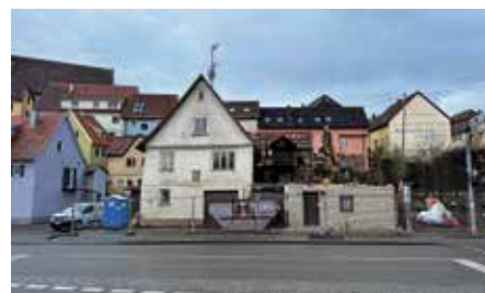
Gebäude Kiesstraße 11 (links), das saniert wird
