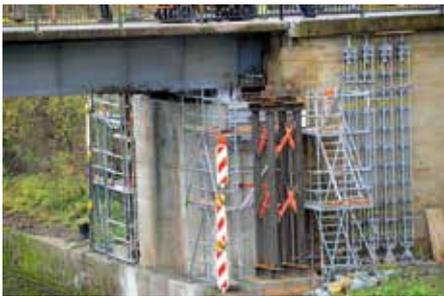
Neben den Brückenpfeilern wurden 4 stählerne Behelfs-Fachwerkpfeiler aufgestellt, auf denen die Fachwerkträger abgesetzt wurden, die die Brücke verstärken werden. Danach werden die Fachwerkträger hydraulisch unter die Brücke geschoben und auf den verbreitert betonierten Brückenpfeilern abgesetzt. Danach werden die Behelfspfeiler wieder entfernt.
