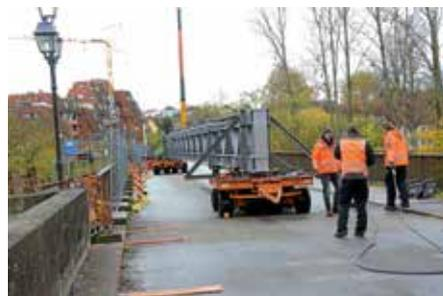
Auf Rollwagen werden die stählerne Fachwerk-Brückenträger einzeln nacheinander per Seilwinde über die alte Neckarbrücke auf die Kanalbrücke gezogen.
