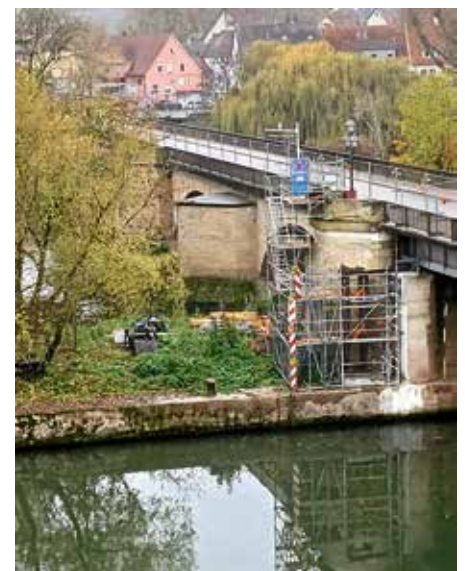
Arbeiten an der Alten Neckarbrücke
