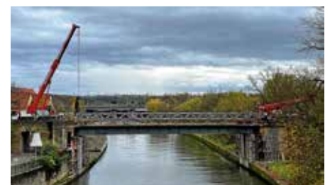
Umbauarbeiten Kanalbrücke Foto: Sarina Pfründer
