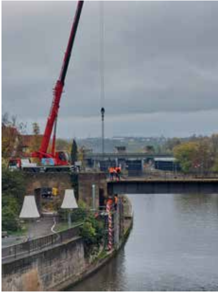
An der Kanalbrücke müssen in den kommenden Wochen Sicherungsarbeiten durchgeführt werden. Dabei kommt es zu unvermeidbaren Verkehrseinschränkungen.
