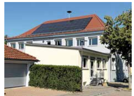
Die neue Fassade der Musikschule mit Photovoltaikanlage
