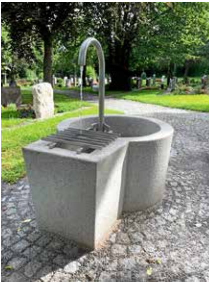
Wasserleitungen auf den Friedhöfen werden am 4. November abgestellt
