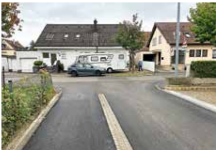
Die Sanierung des Hainbuchenwegs konnte abgeschlossen werden
