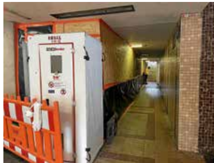
Sanierung der Bahnunterführung ist gestartet
