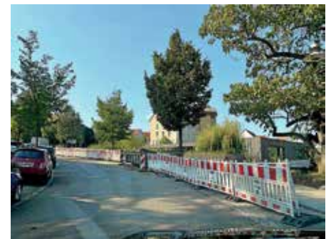
Die Baumaßnahmen zur Radachse entlang der Körnerstraße sind angelaufen
