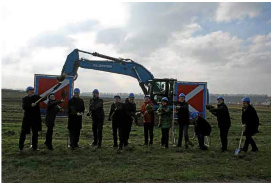
Spatenstich Obere Seugen II im Februar 2015
