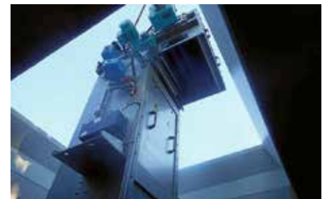
Der große Rechen wird in das Pumpwerk Städtle eingebaut.
