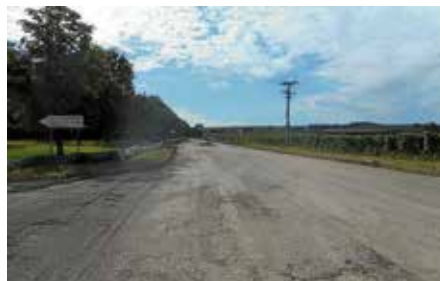
Umfangreich wird die Fahrbahndecke Richtung Kirchheim a.N. saniert.
