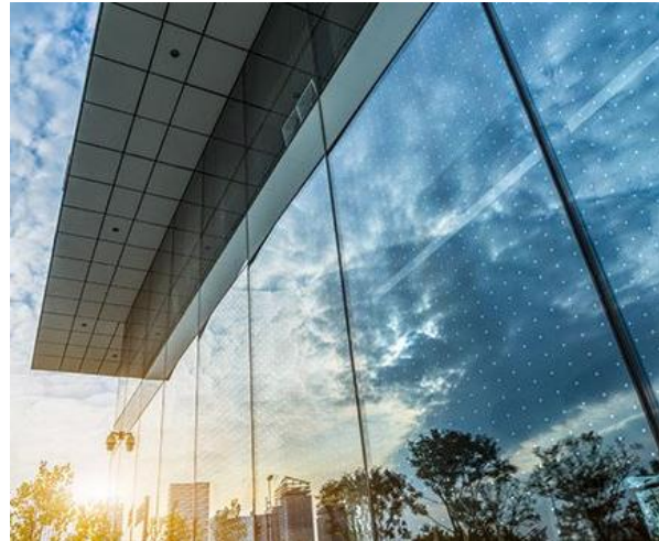
Abb. 10: Glasfassade mit Punktmuster, Quelle: SEEN AG
