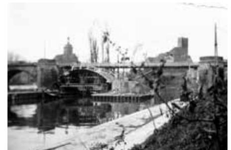
Das Bild zeigt den Abbruch des Pfeilers der alten Kanalbrücke
