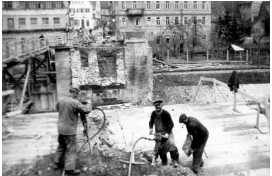
Das Bild zeigt den Abbruch der alten Kanalbrücke mit dem Behelfssteg
