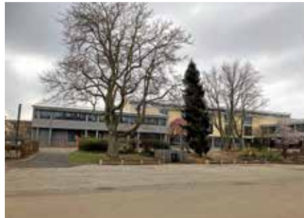
Erich-Kästner Schule und Werkrealschule nach der Sanierung
