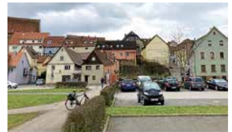
Wohngebäude Kiesstraße 11 u. 13
