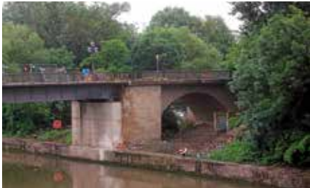
Aktuelle Baustelle an der Alten Neckarbrücke
