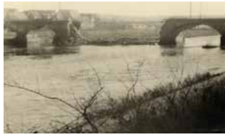
Die alte Neckarbrücke nach Sprengung durch abziehende deutsche Truppen am 5. April 1945
