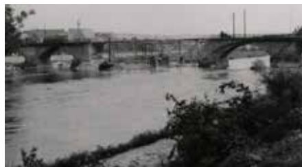
Wiederaufbau der Brücke 1945/1946
